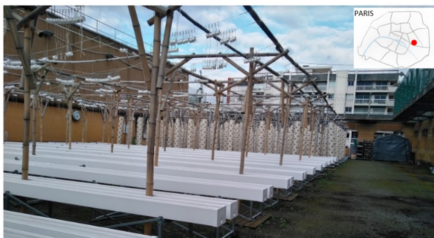
Figure 1 : Vue générale du toit de la piscine Cour des Lions (source : P.OHEIX)
