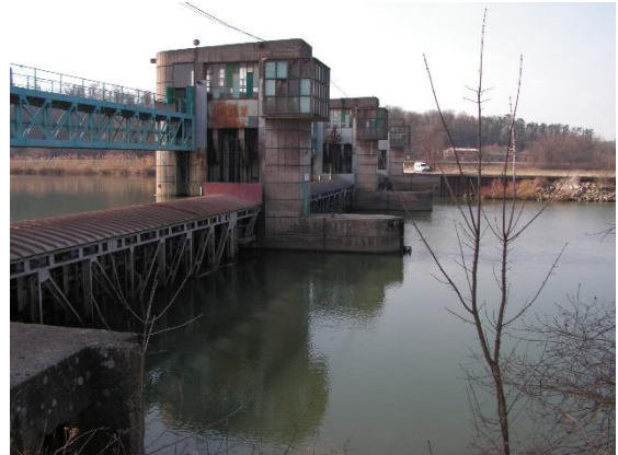
Figure 4 : Barrage d'Autreville-sur-Moselle permettant le fonctionnement d'une microcentrale hydroélectrique.
