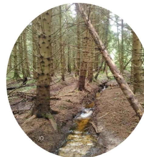
Pour le drain : Un tracé rectiligne, une section symétrique en trapèze
