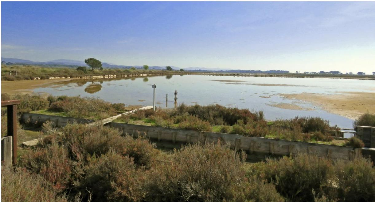
PLANCHE 1 : VUE SUR LE BASSIN 4, AU CŒUR DES VIEUX SALINS. AU PREMIER PLAN, CANAUX ET « CANON » EN BOIS, PERMETTANT LA GESTION HYDRAULIQUE DU SITE. AU CENTRE, ECHELLE DE MESURE POUR LES RELEVÉS PHYSICO-CHIMIQUES.
