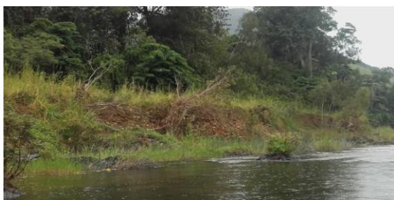
Figure 31. Zone d'érosion située plutôt à l'aval.
