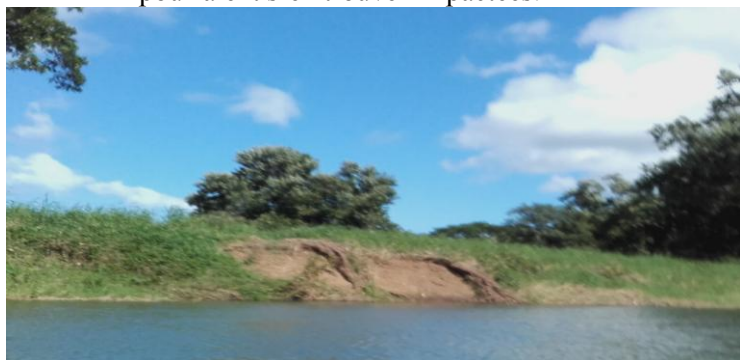
Figure 39. Constatation de l'état de la végétation rivulaire en RD (aval du pont)
