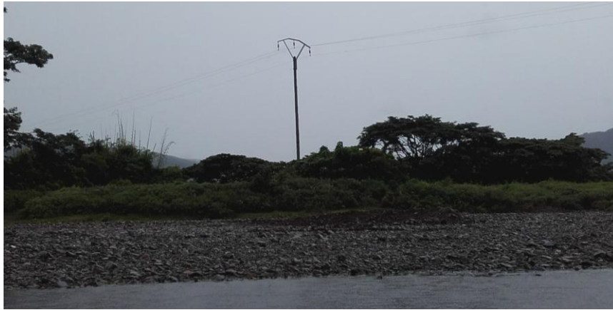
Figure 38. Vue des poteaux électriques situés à quelques mètres seulement du cours d'eau Crédit : Stéphanie LETONNELIER
