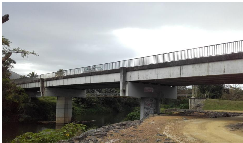
Figure 23. Photo prise de la rive gauche en aval du pont de la RT1. Crédit : Florent VIDAL
