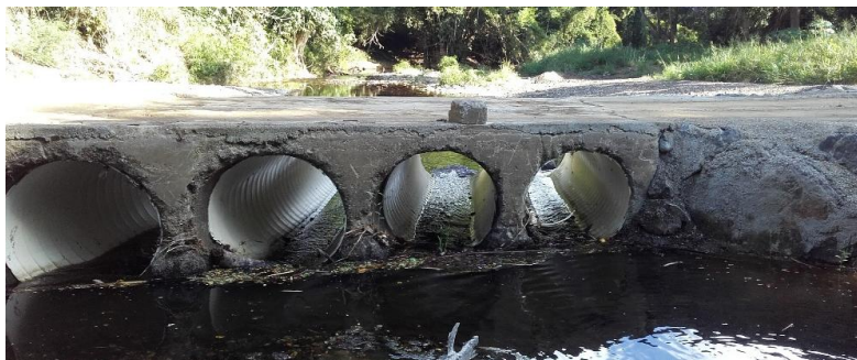
Figure 28. Radier en béton formé de 4 buses sur la Pocquereux en aval du PM6000
