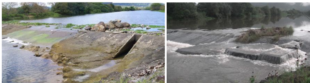
Figure 7. Etat du barrage anti-sel avant (photo de gauche) et après travaux (photo de droite). Source : Analyse diagnostic des barrages anti-sel de 2017 par Agri-pole.
