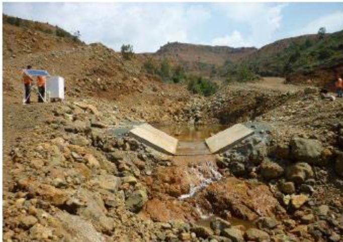
Figure 12 : Seuil utilisé pour le protocole Hydromine
