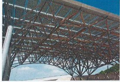
Illustration n°13 : Treillis en mélèze, Canopée solaire, Doncaster.. Angleterre, Architecte : Felden Clegg
