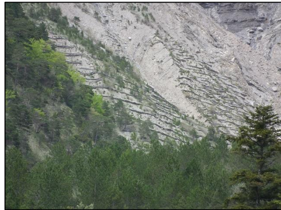
Figure 17. Nouvelles tentatives de plantations sur banquette au niveau du torrent du Praver, FD RTM du Grand Ferrand.
