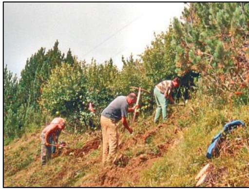
Figure 34. Piochage de micro-banquettes (RTM 73).
