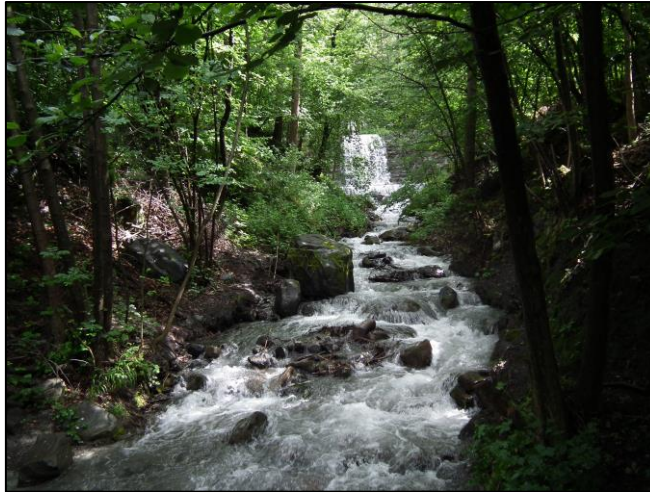
Figure 47. Partie aval du torrent de la Grollaz, FD RTM du Pas-du-Roc.
