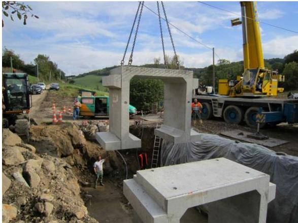
Figure 35 : Pose de PIPO sur le Cartelier à Rontalon (69) (SMAGGA, 2013). 96 000€ HT
