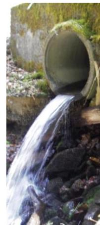
Figure 21 : L'ouvrage infranchissable typique d'après les relevés effectués sur le terrain
