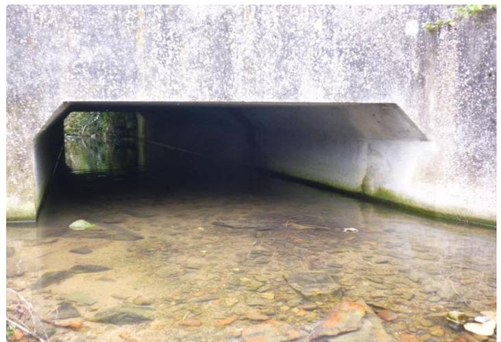
Figure 10 : Intersection du Ruisseau des Aulnées et de la D25 à Sérécourt (88) : un exemple d'ouvrage parfaitement franchissable d'après les photos.
