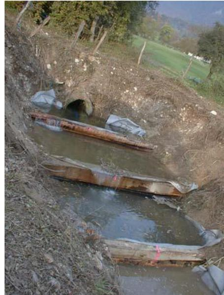
Figure 38 : Aménagement en sortie de buse sur Le Véise à Gruffy (74) - Syndicat Mixte Interdépartemental d'aménagement du Chéran.
