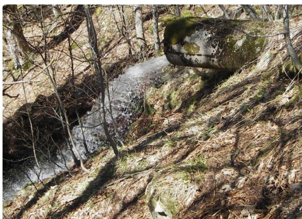
Figure 15 : Exemple d'infranchissabilité naturelle du fait d'une très forte pente. Vologne sous D34C
