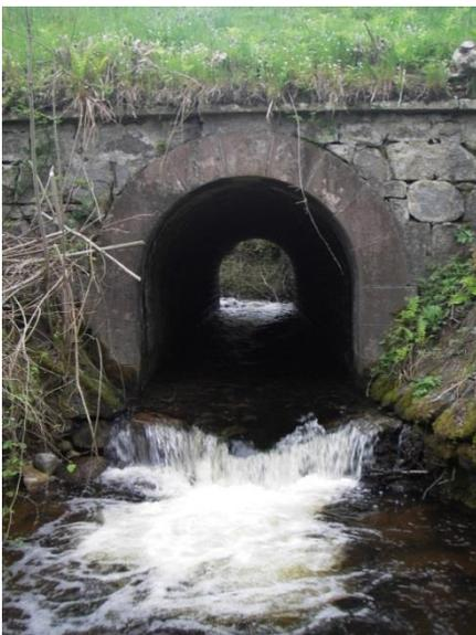
Figure 11 : Intersection du Grand Rupt et de la D43D à Cleurie : le type d'ouvrage pour lesquels un diagnostic sur le terrain est nécessaire.
