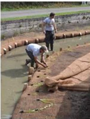
◀ Plantation d'hélophytes après mise en place d'un géotextile et remplissage avec des matériaux terreux
