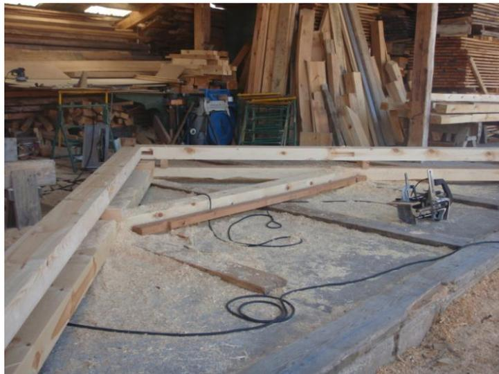
Photo 7 : Montage d'une ferme de charpente traditionnelle en Pin sylvestre
