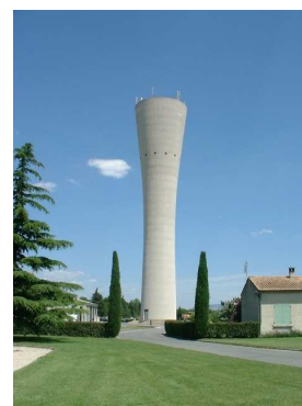
Château d'eau du SIVOM Durance Alpilles. ( http://www.sivomdurancealpilles.fr )
