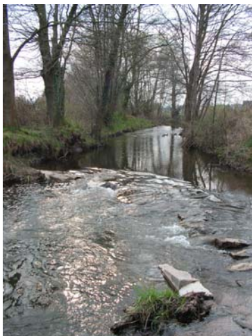
▲ Ancien seuil aujourd'hui quasiment disparu
