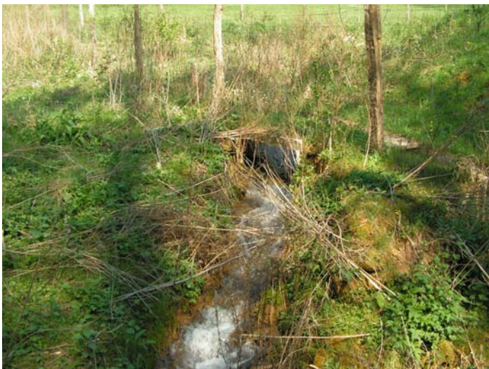
▲ Installations observées en aval direct du plan d'eau
