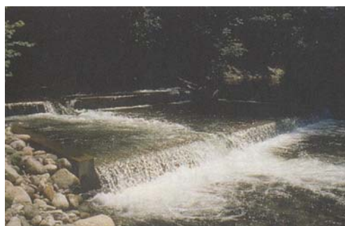
Prébarrage de Sinsat sur l'Ariège (09) (Photo : Larinier et al. 1994)
