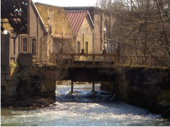
Seuil mobile à vannes (ouvertes) sur la Vence (Photo : Monnier)
