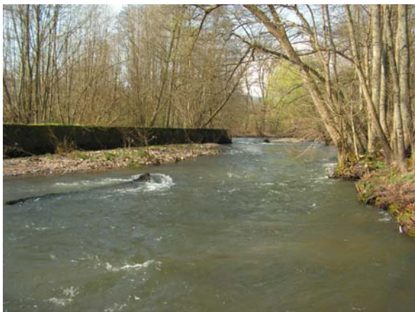
Figure 27 : Digue (a) et seuil (b) de protection de la voie ferrée sur la Bruche à Heiligenberg
