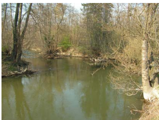
◀ Ancien seuil du Rothmuhle aujourd'hui totalement démolé
