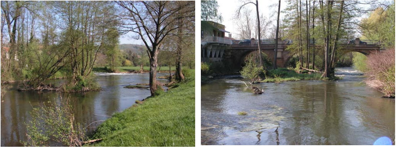
Figure 22 : Situation à l'aval du barrage de Montmédy
