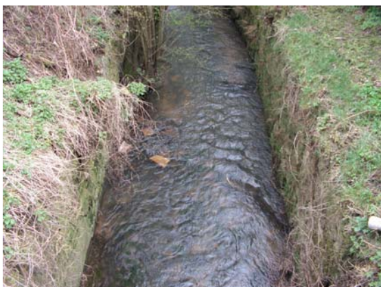
◀ Vue du ruisseau aménagé avant l'entrée du moulin
