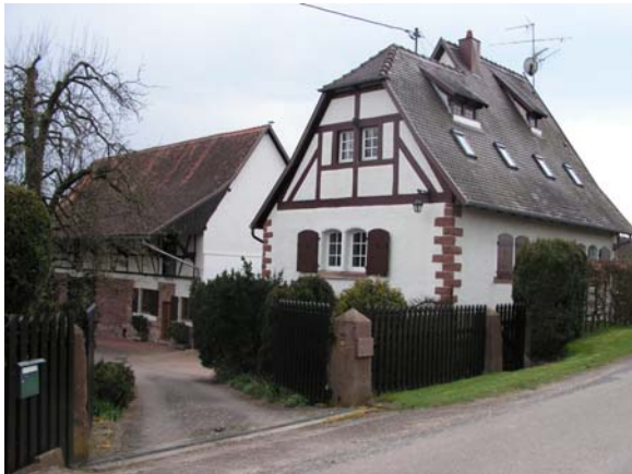
◀ Moulin de Still actuellement habité. Il n'est vraisemblablement plus utilisé en tant que source d'énergie mais il est impossible de dire si ce dispositif est franchissable.
