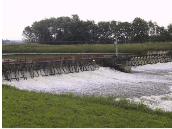
Barrage à aiguilles à Létanne sur la Meuse (08) (Photo : Beinsteiner)
