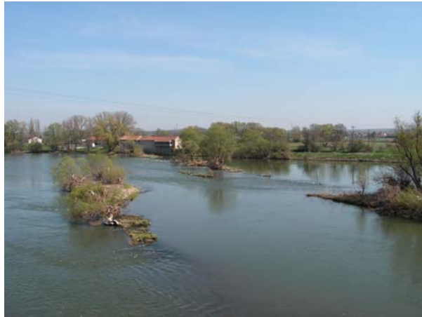
▲ Ancienne digue d'alimentation du moulin aujourd'hui quasiment disparue et totalement franchissable par le poisson
