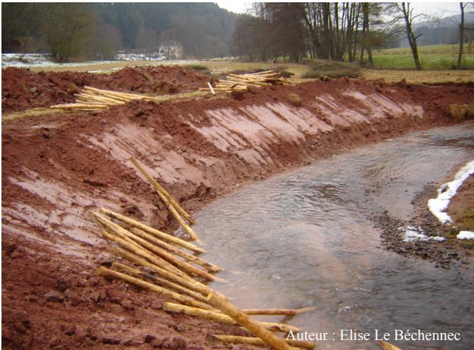
photo 10 : résultat obtenu après retalutage sur le Hure au niveau de l'érosion de berge
