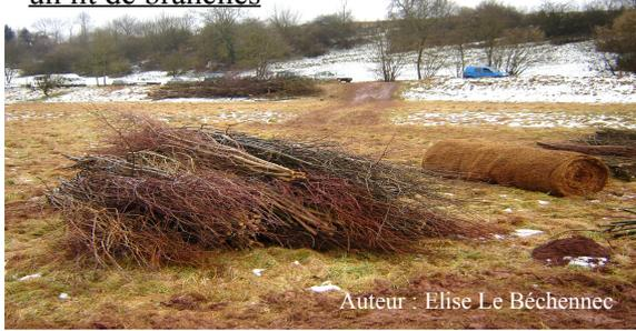
photo 12 : lit de branches posé sur le Hure au niveau de l'érosion de berge
