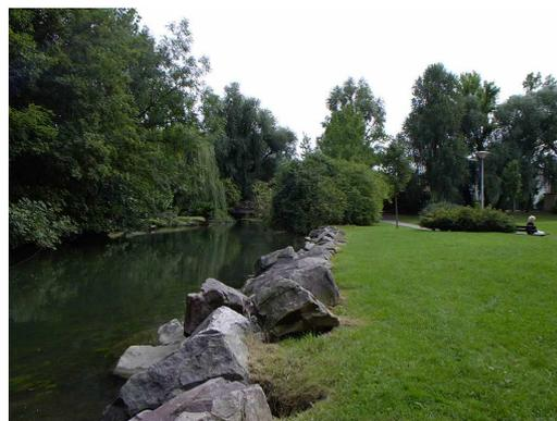
Figure 28 : Consolidation de berge par enrochement
